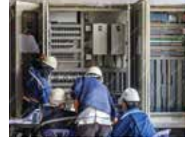
Electrical Engineers مهندسين كهربائيين
